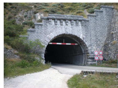
Tunnel du Roux
