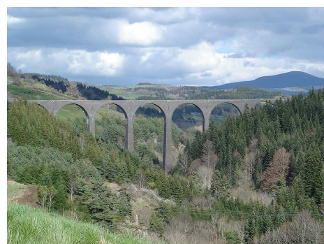
Viaduc de la Recoumène
