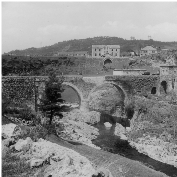
Ancien pont de la Palisse. Au loin nous apercevons l'école
