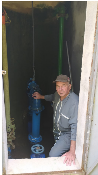
Nettoyage et vérification des trois réservoirs sur la commune.
