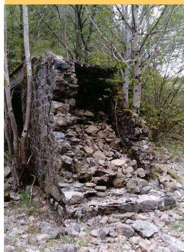
Vestige d'un pilier de l'ancienne passerelle
